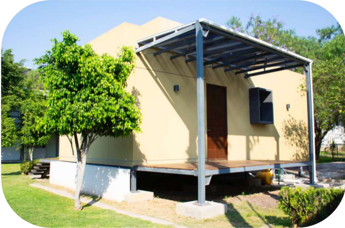
Figura 1. Parte posterior para intervención de los habitantes de Casa Solar Experimental.
