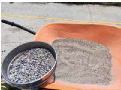
Fig. 3 Cribado del material fino de concreto reciclado.
