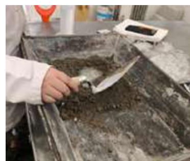
Fig.4 Preparación de mezclas de concreto.
